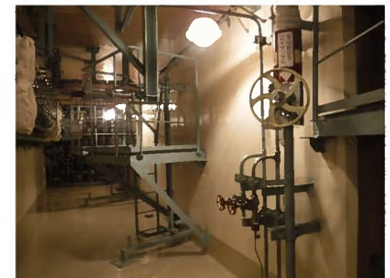
原子炉格納施設等 内部コンクリート (1号炉)
