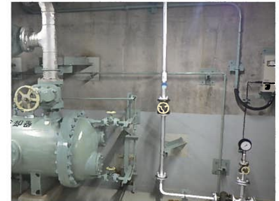
原子炉補助建屋 内壁及び床 (2号炉)
