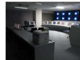
非常用照明点灯時
