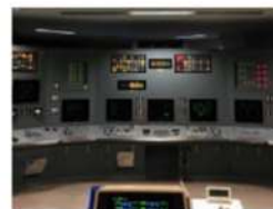
直流照明兼非常用照明点灯時のイメージ (写真：シミュレータ施設)
