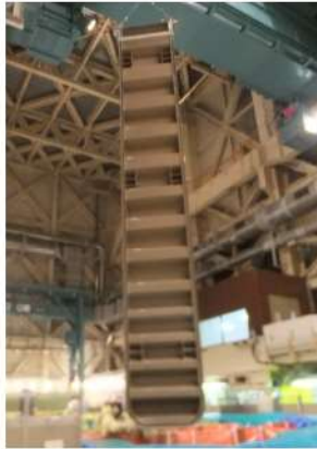
ゲート吊上げ作業 (写真は2号機)
