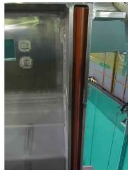
ゲートパッキンの装着状況
