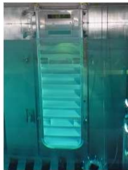
ゲートの設置状況
