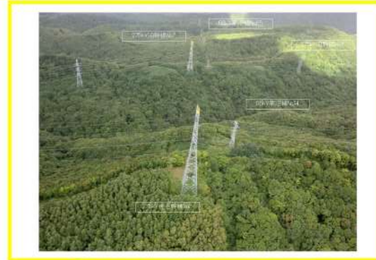
第2.2.3.5図 ③交差箇所の現地状況
