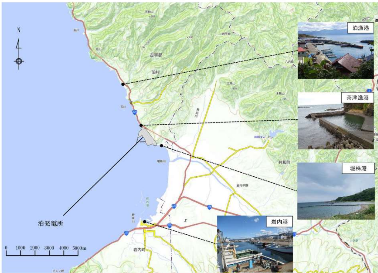
図 2.5-12 泊発電所周辺の地形
