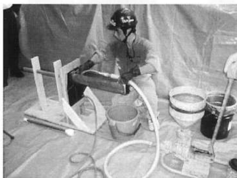
グラウトの充てん状況
