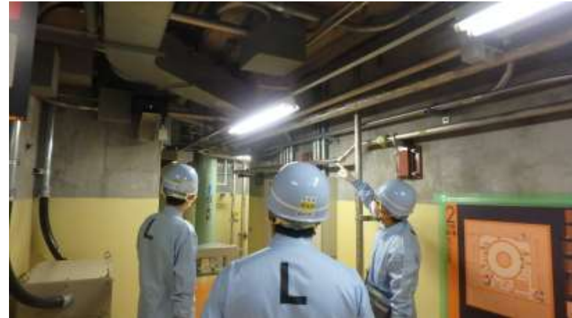
現場確認の例②
