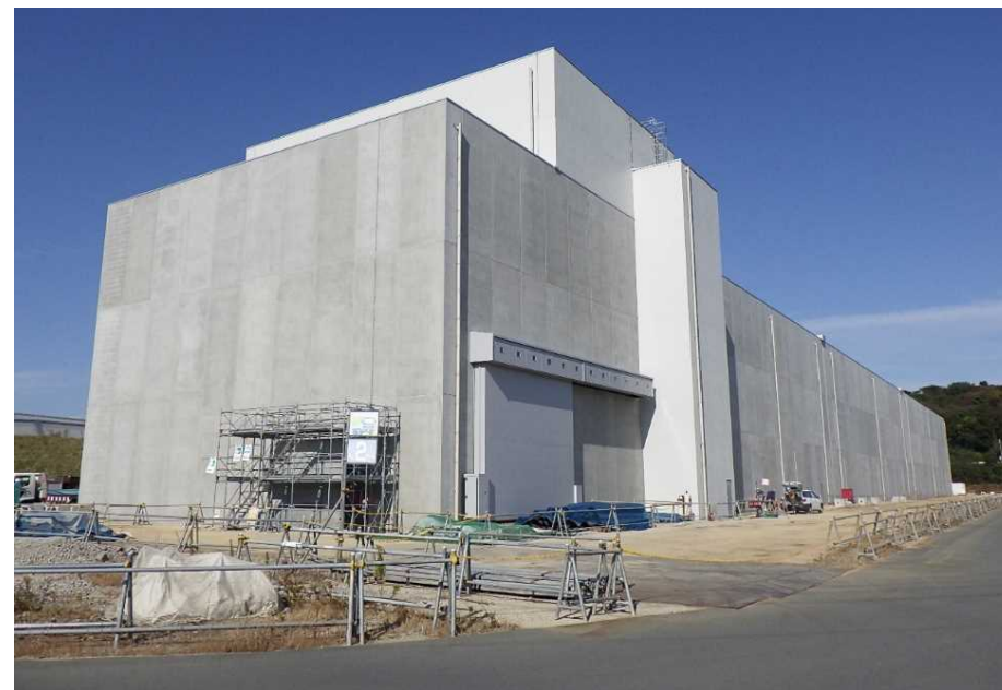
【現場状況：南面・東面】
