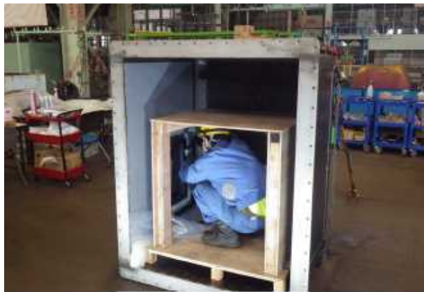
金属板取付け
