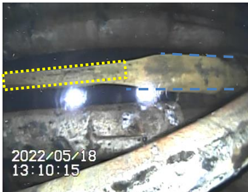
水面より上のRCW配管の状況
