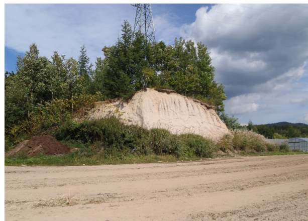
露頭②全景 (底盤標高:約28m, 上面標高:約37m)
