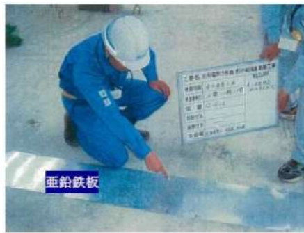
図5 集水管及びサブドレンの敷設状況写真（泊3号炉建設時）
