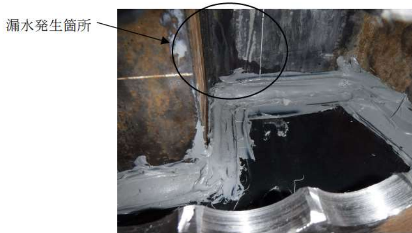
図 26 漏水状況
