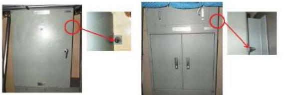
図2 電源盤のボルトによる壁面固定
