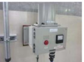
図2 機器のボルトによる壁面固定
