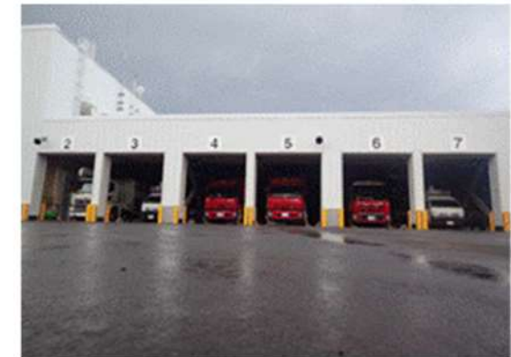
51m倉庫車庫エリアにおける可搬型設備の保管状況
