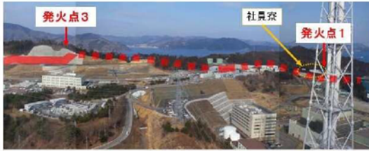
第2.3.1.2-3図 自然現象監視カメラ（北側監視）視野と発火点の位置
