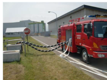
水源への吸管挿入 (屋外 T.P. 10.3m)
