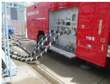
可搬型大型送水ポンプ車の設置 ポンプ車周辺のホース敷設 (屋外 T. P. 10m)
