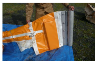
荷揚場シルトフェンス端部
