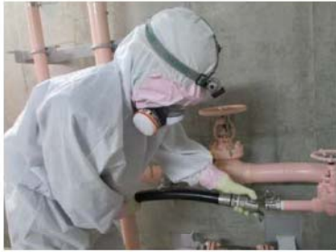
燃料汲み上げ用ホース接続及び敷設 (ディーゼル発電機燃料油サービスタンク室) (原子炉建屋 T.P.17.8m)
