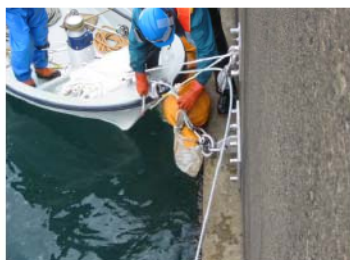
間口部シルトフェンスと 固定金具接続
