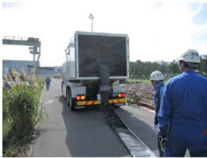
ホース延長・回収車による 可搬型ホース敷設
