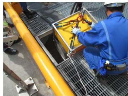
海水取水箇所への水中ポンプ設置
