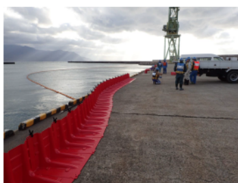
荷揚場シルトフェンス設置状況 (赤の遮水壁：ボックスウォール)
