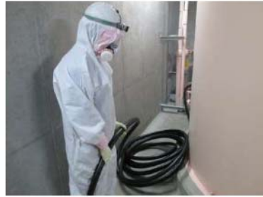
燃料汲み上げ用ホース接続及び敷設 (ディーゼル発電機燃料油サービスタンク室) (原子炉建屋 T.P.17.8m)
