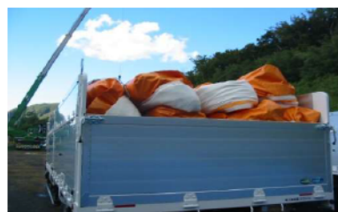
間口部シルトフェンス積載状況 (連結状態で積載)
