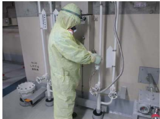
(制御用空気供給弁閉操作イメージ)
