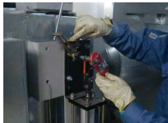
(空気作動ダンパ閉作業イメージ)
