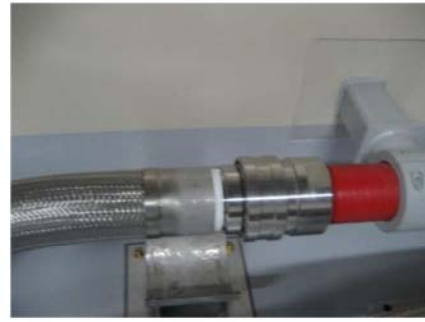
消火水系統と格納容器スプレイ系統の 接続のためフレキシブル配管接続後
