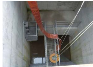
海水取水箇所への水中ポンプ設置 (屋外 T. P. 10m)
