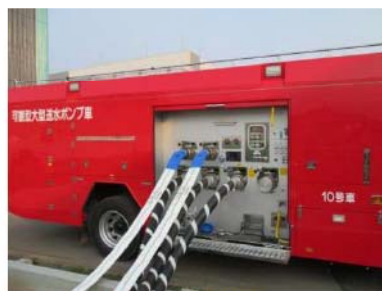
可搬型大型送水ポンプ車 周辺のホース敷設 (屋外 T. P. 31m)
