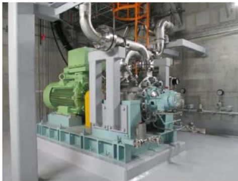
代替格納容器スプレイポンプ （原子炉建屋 T. P. 10. 3m）
