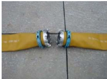
可搬型ホース (150A) 接続口
