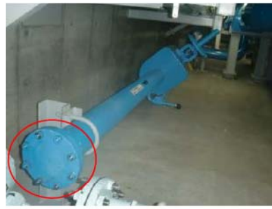
原子炉補機冷却水系統の 可搬型ホース接続口 (原子炉建屋 T. P. 2. 3m)
