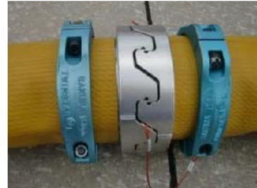
可搬型ホース (150A) 接続後
