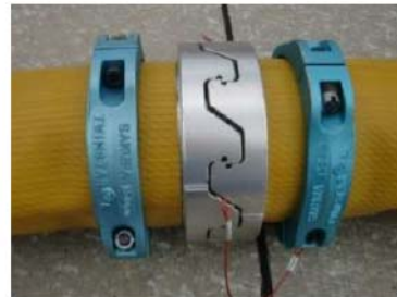
可搬型ホース (150A) 接続後
