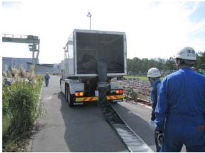
ホース延長・回収車による ホース敷設 (屋外 T.P. 10m)
