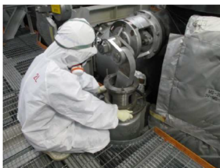
主蒸気隔離弁増締め操作 (原子炉建屋 T.P. 33.1m)
