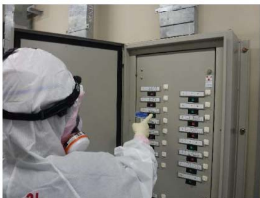
加圧器補助スプレイ弁電源入 (原子炉補助建屋 T.P. 10.3m)
