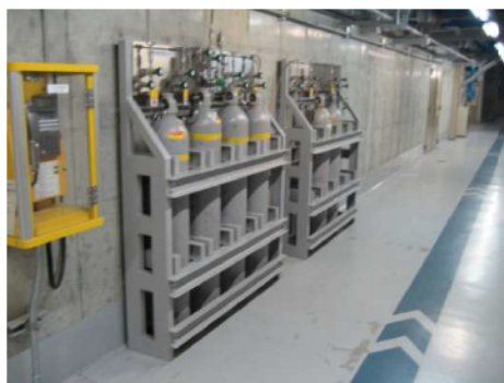
主蒸気逃がし弁操作用 可搬型空気ポンベ (原子炉建屋 T.P. 10. 3m)
