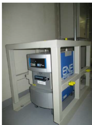
加圧器逃がし弁操作用バッテリー （原子炉補助建屋 T.P. 10. 3m）
