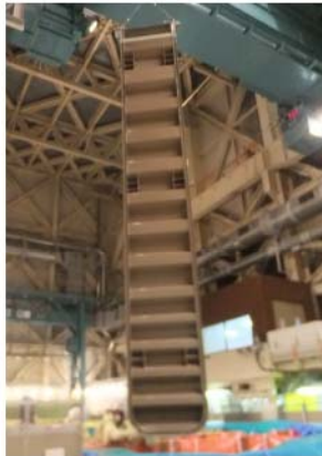
ゲート吊上げ作業 (写真は2号機)
