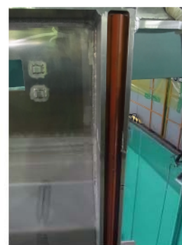
ゲートパッキンの装着状況
