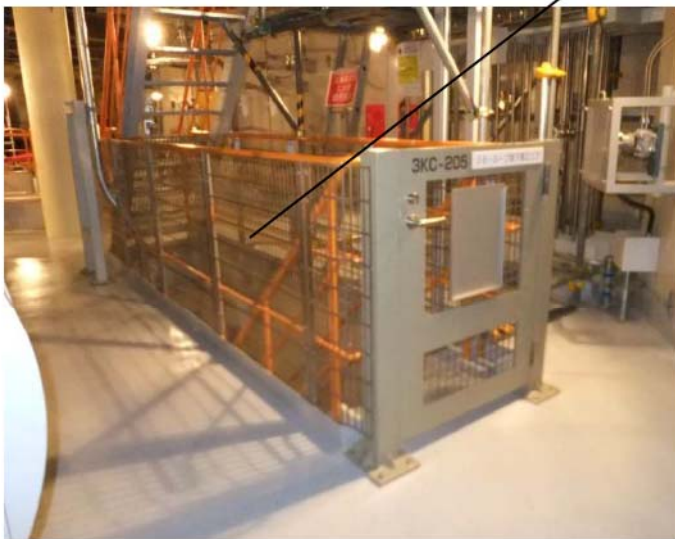
(写真B) 階段開口部に設置したパンチングメタル
