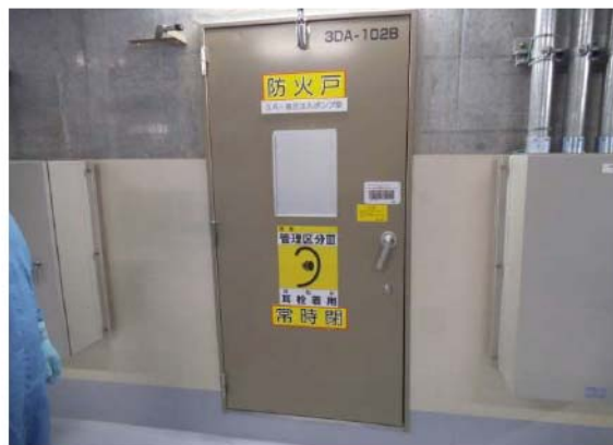
(4) A-高圧注入ポンプ室扉
