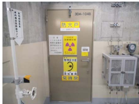
(8) A-余熱除去ポンプ室扉
