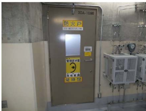
(5) B-高圧注入ポンプ室扉
