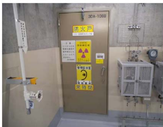
(9) B-余熱除去ポンプ室扉
