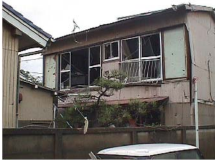
激しく損壊してしまった民家
