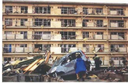
5階建て集合住宅南面の被害状況
