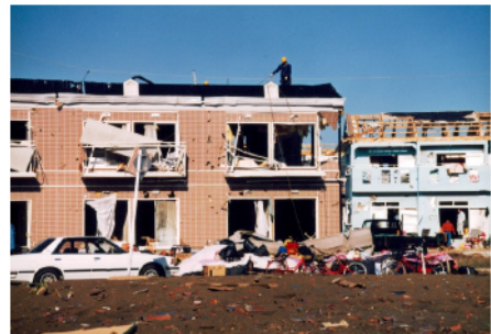
竜巻被害状況 (損傷した建物)
