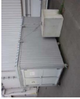
図1 コンテナの飛散防止対策例
