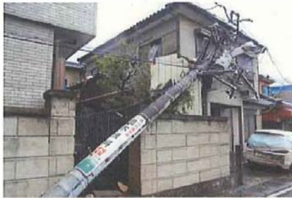
電柱の折損・傾斜
