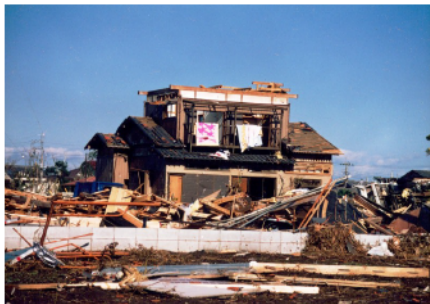
竜巻被害状況 (損傷した建物)
