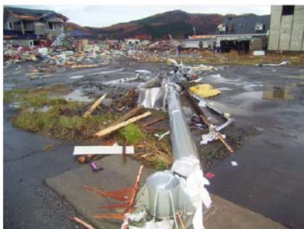
道路標識の折損
