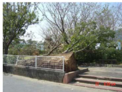
写真38 樹木の転倒(緑ヶ丘)
