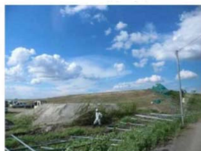
写真 5.2.20 フェンスの被害
