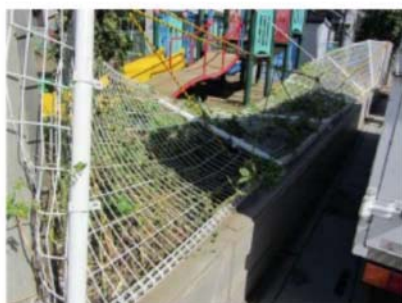
写真 4.1.14 フェンスの倒壊
