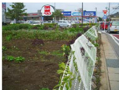
写真 31 フェンスの変形
