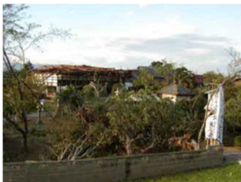
写真1 天神寺外観(南から見る)
