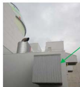
建屋開口部Ⓑ (屋外から撮影)
