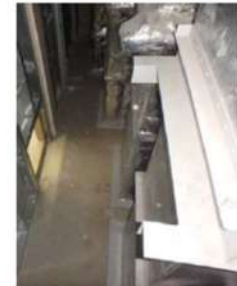
点検口を北側に見た床面②
