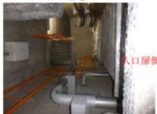
グレーチング上で西側を向き見下ろした床面③
