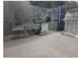
室内東側から見た床面③
