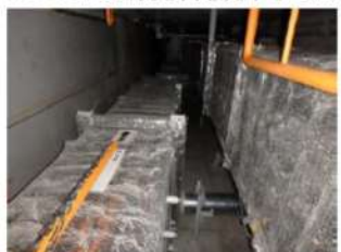
グレーチング上で西側を向き見上げた天井⑤
