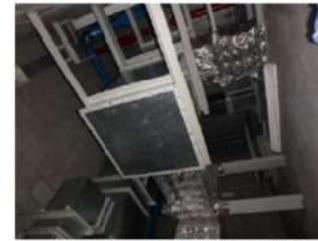
室内東側から見上げた天井④
