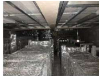
点検口から見上げた天井③
