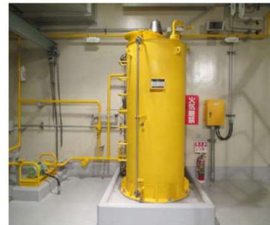
図-7 1次冷却材ポンプ電動機油回収系統
