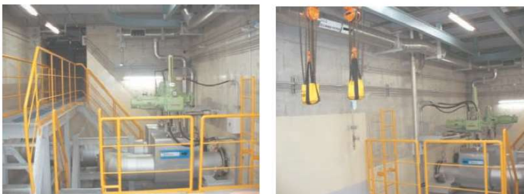
図-6 A,B-安全注入ポンプ再循環サンプ側入口 C/V 外側隔離弁周辺の状況
