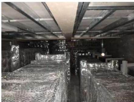
点検口から見上げた天井③
