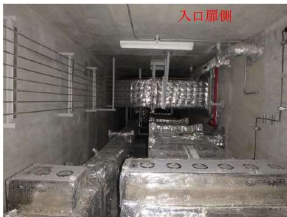
室内中央で西側を向き見上げた天井③
