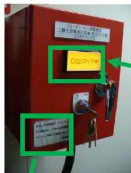
写真③ 放出ロック盤
