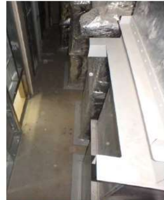
点検口を北側に見た床面②
