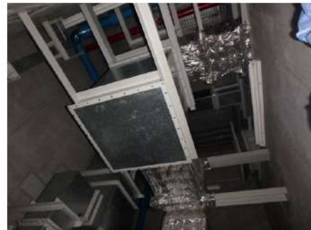
室内東側から見上げた天井④
