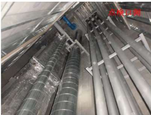
点検口を東側に見上げた天井③
