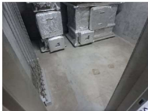
入口扉から見た床面②
