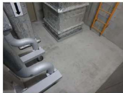
室内南西側から見た床面②
