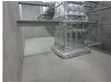
入口扉から見た床面②
