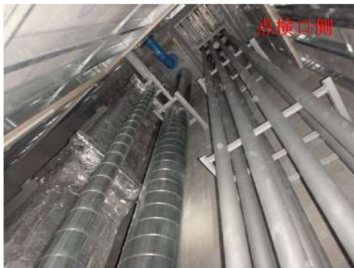
点検口を東側に見上げた天井③
