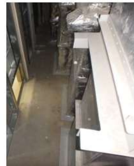
点検口を北側に見た床面②
