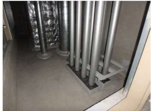
点検口から見た床面②
