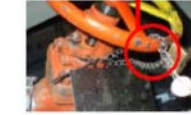
原子炉圧力容器ドレンライン 【CLW RPV 第一ドレン弁（G31-F503X）】
