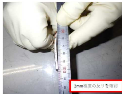
ボルト及び座金等 締結部材の状態
