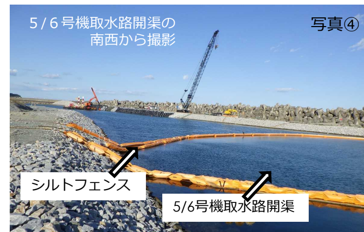
5・6号機海側工事エリアの状況
