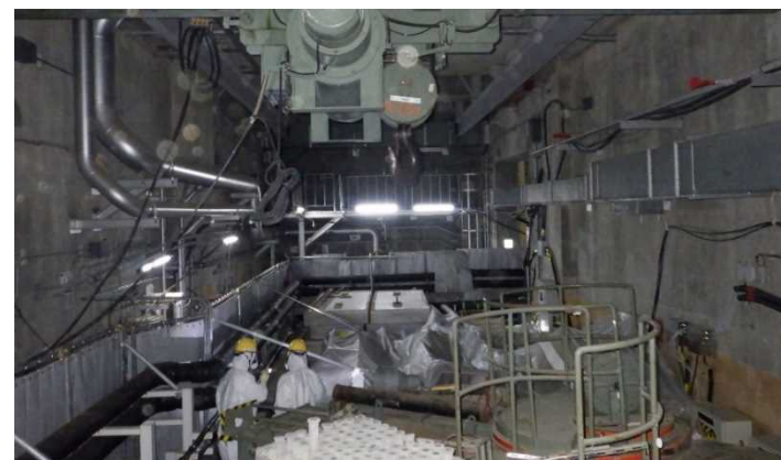
ハッチ付近 (ROV投入箇所)
