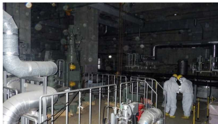
建屋西側付近 (容器搬出入箇所)
