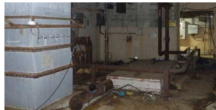
中央ハッチ付近 (ROV投入箇所)
