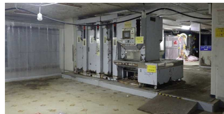
補機設置予定エリア付近
