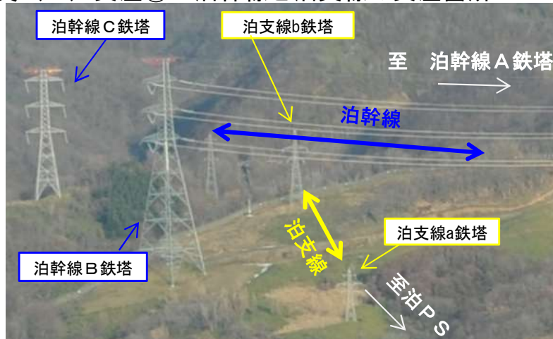
写真(1) 交差①：泊幹線と泊支線の交差箇所
