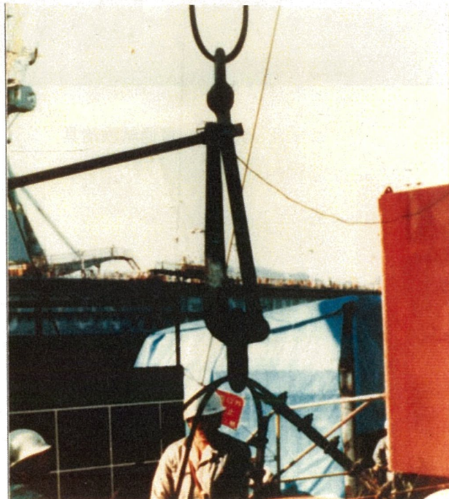
写真4 切り離し装置使用状況
