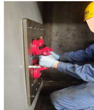
金属板取付け（バキュームリフターによる把持）
