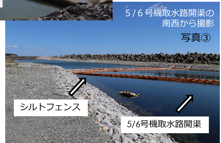
5・6号機海側工事エリアの状況
