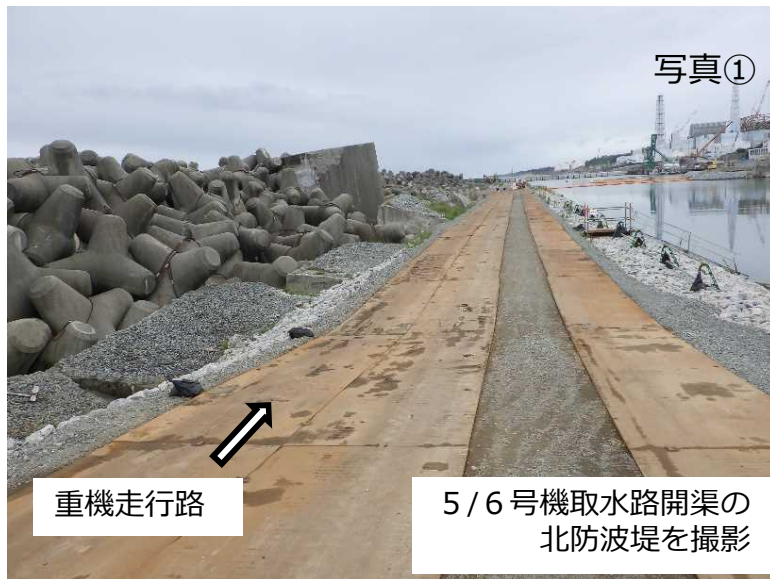
重機走行路整備の状況
