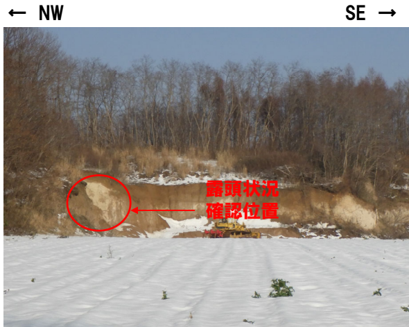
露頭①全景 (底盤標高:約20m, 上面標高:約35m)
