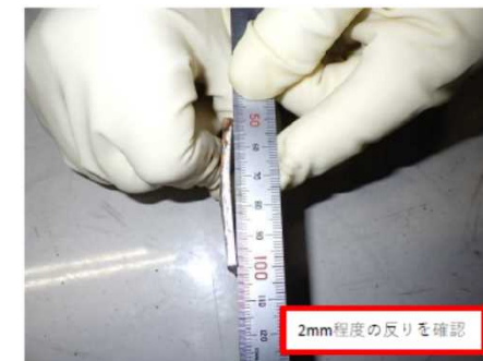
ボルト及び座金等 締結部材の状態
