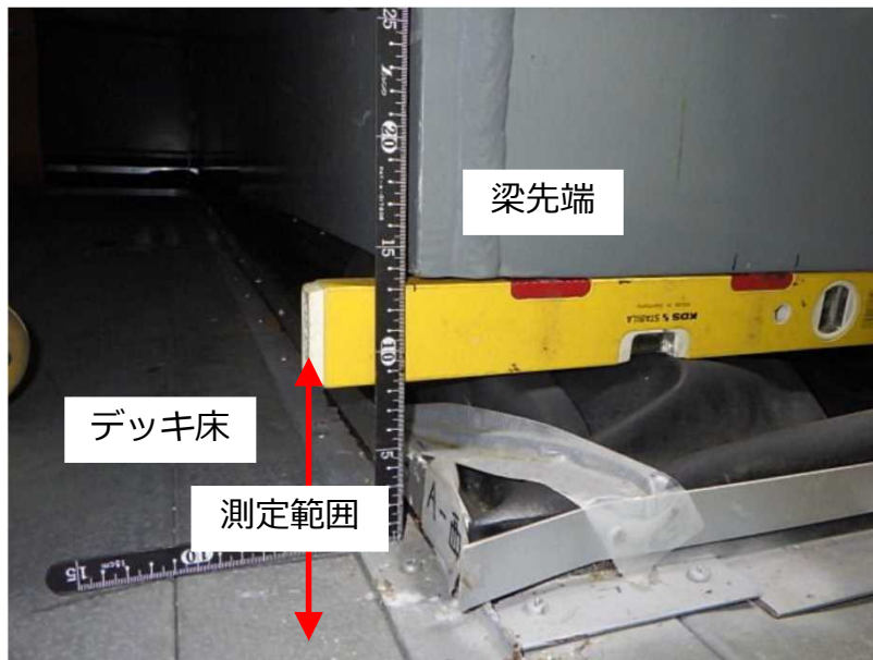
【梁先端部 計測状況】
