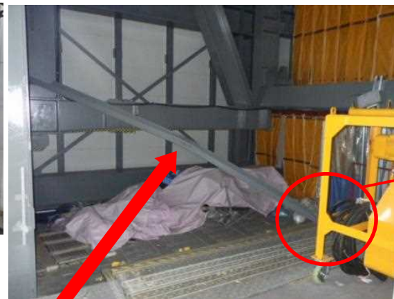
【写真④】 鉄骨補助部材が破断した箇所 （内側から撮影）
