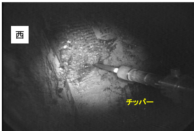
西側炉底傾斜面上部のはつり作業(R4.1.18)
