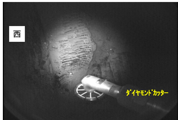
西側炉底傾斜面上部のはつり作業(R4.1.7)
