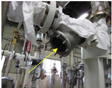
①ストレーナ内部
