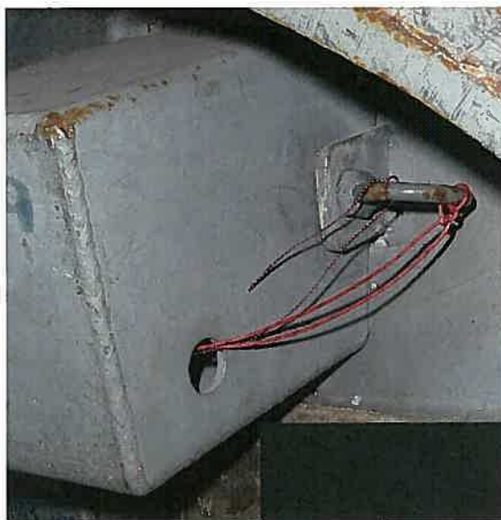
③写真 毀損した査察用封印(2)
