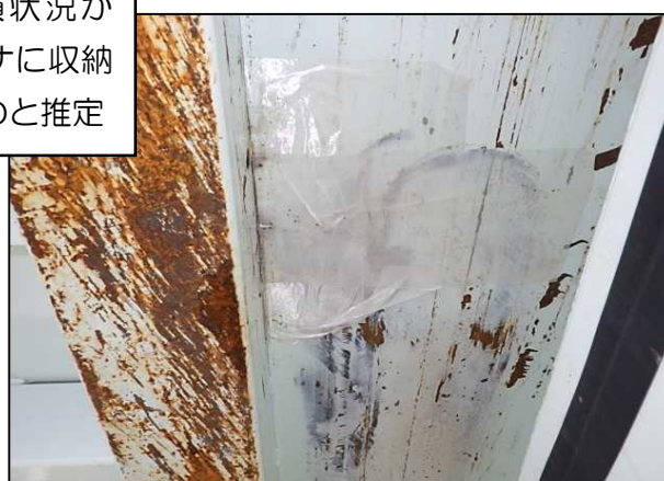
コンテナ3（補修後）
