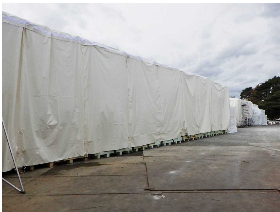
耐候性シート養生
