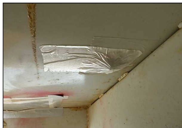
コンテナ2（補修後）
