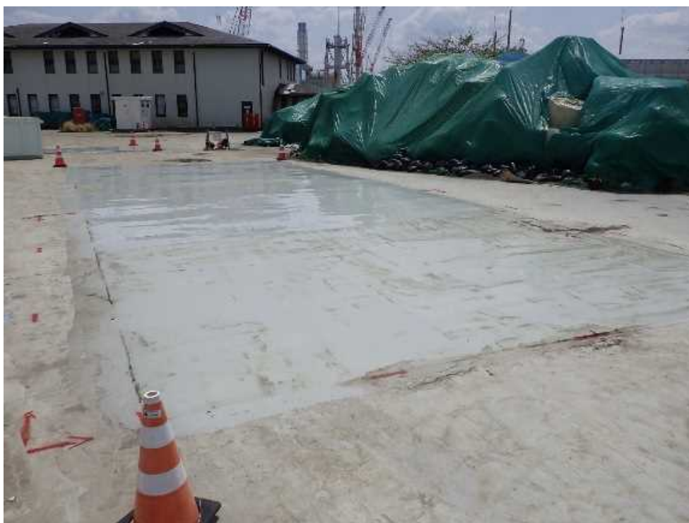
アスファルト再舗装（4月15日）塗装（4月16、19日）（ 70\mu\text{m} 線量当量率が高い箇所）
