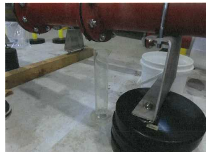
モックアップ試験の状況
