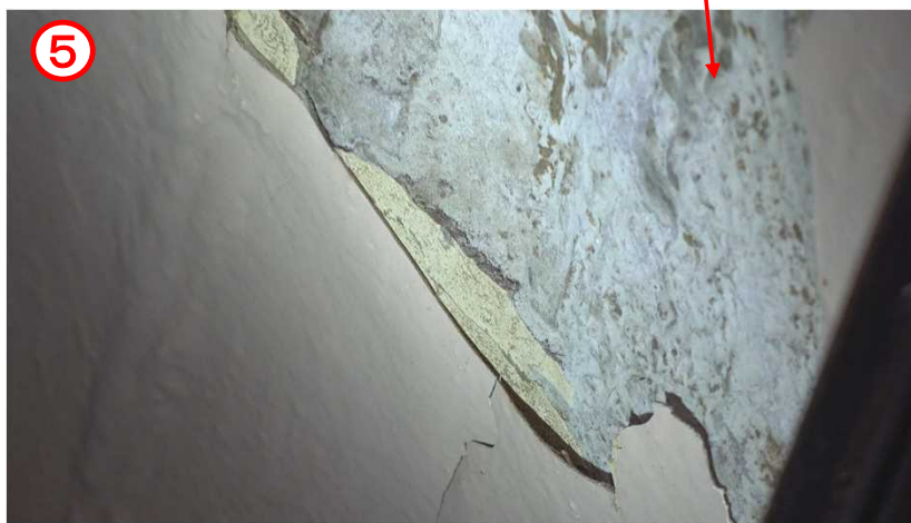
塗料(ペDESTAL内)
