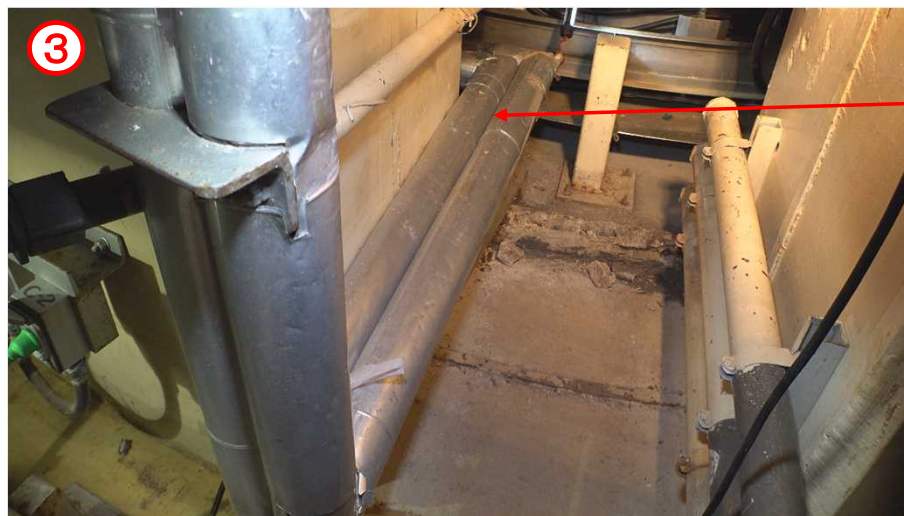
原子炉補機冷却水系配管保温材 ペデスタル地下 保温材カバーあり
