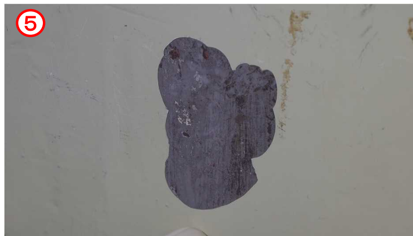
塗料(ペDESTAL内)
