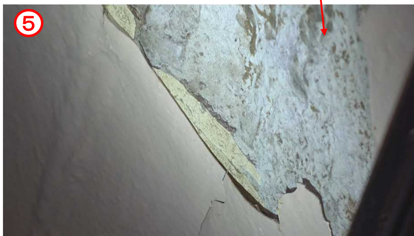
塗料（ペDESTAL内）
