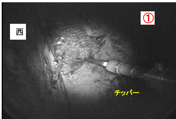
①西側炉底傾斜面上部のはつり作業(R4.1.18)
