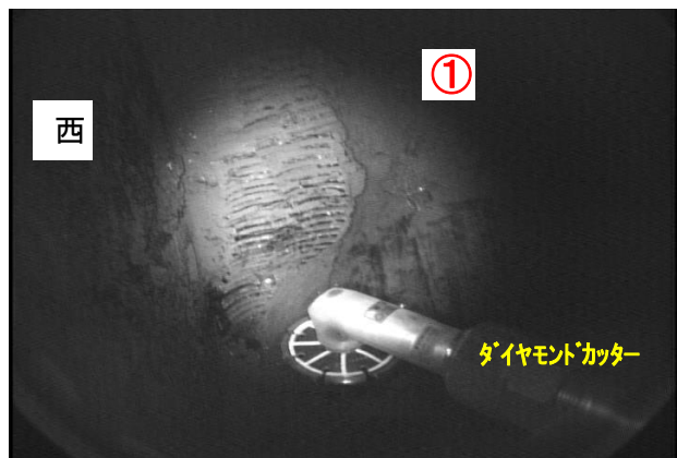
①西側炉底傾斜面上部のはつり作業(R4.1.7)
