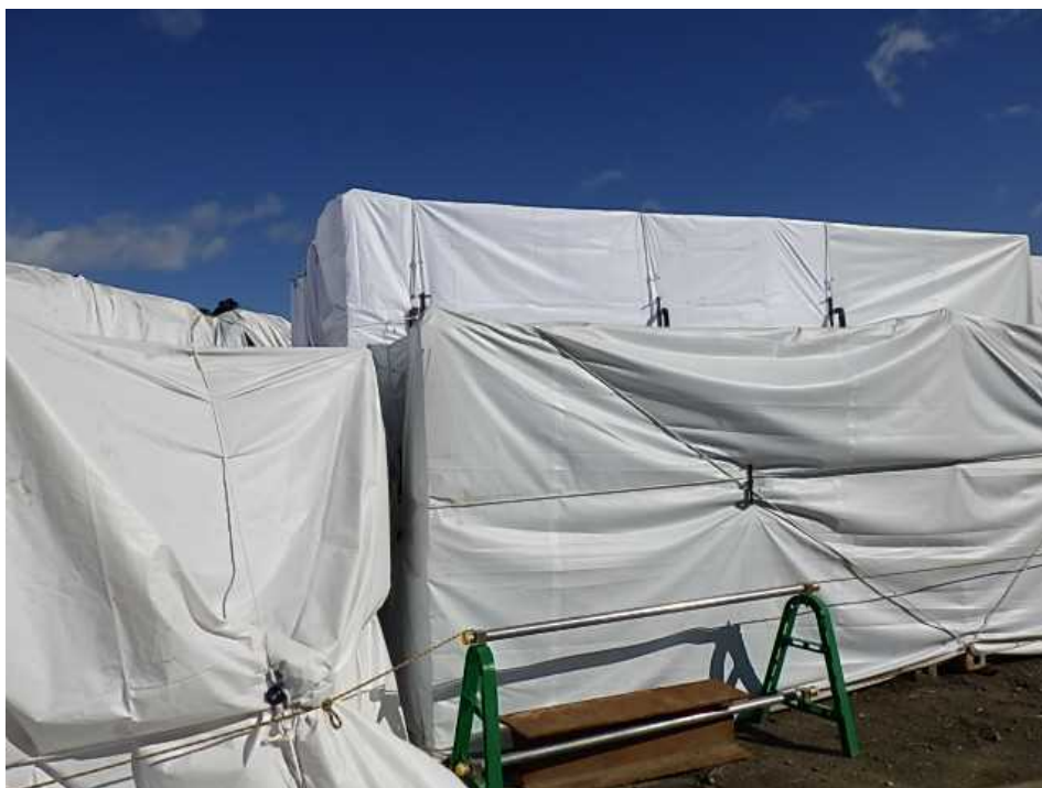
仮設シート養生
