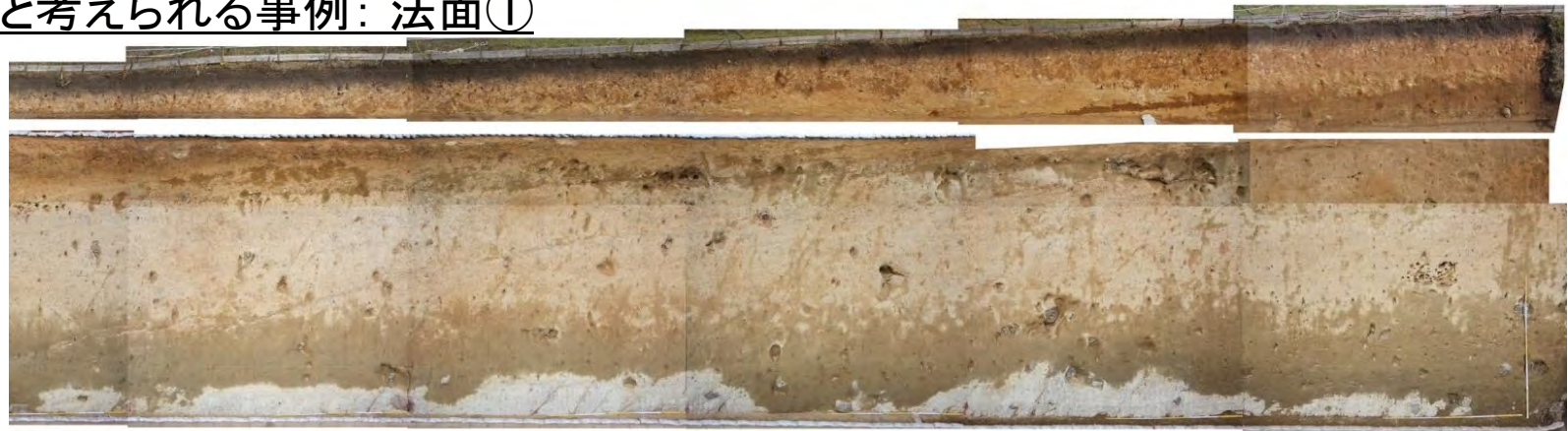
法面①写真
